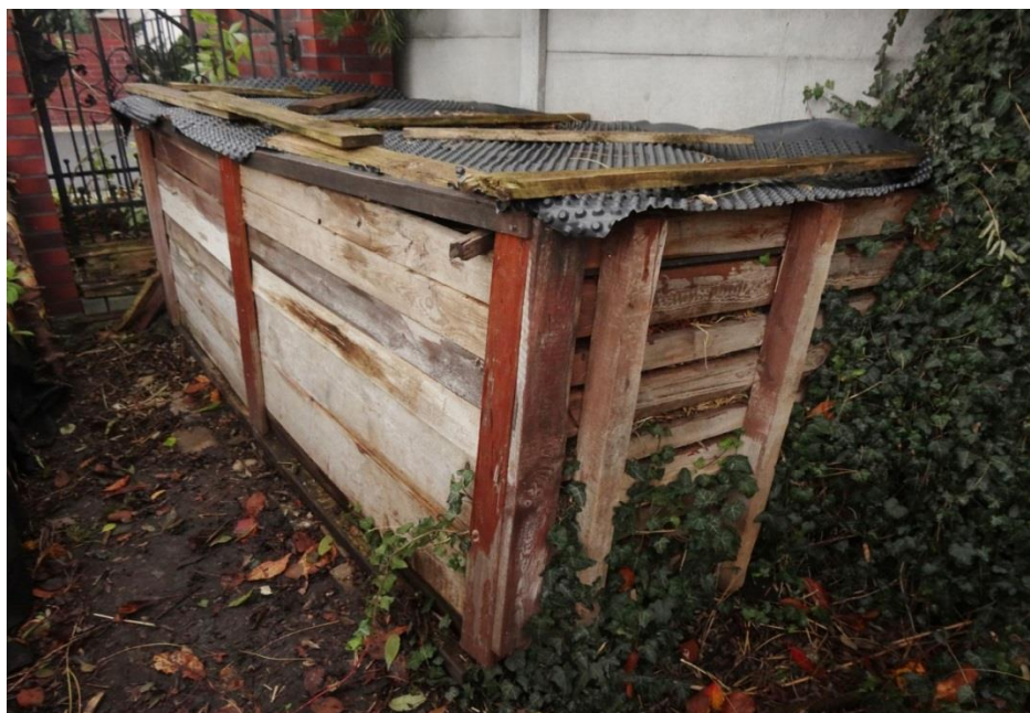
Ryc.4 Kompostownik wykonany z palet i starych desek. Potrzebna też będzie garść wkrętów i wkrętarka. Przykrycie jest konieczne - przyspieszy kompostowanie i zabezpieczy przed wizytami zwierząt.
