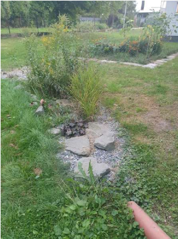
Ogrody deszczowe w Skawinie zapobiegają spływaniu wody do kanalizacji i wspierają lokalną bioróżnorodność.
